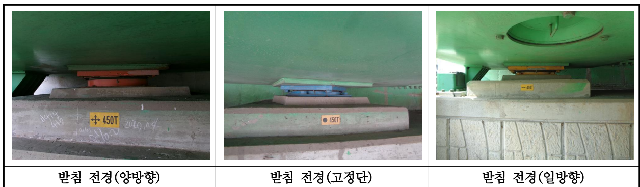
【사진 2.3.10】 교량받침 전경
