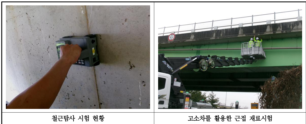
【사진 2.4.2】 철근탐사 시험
