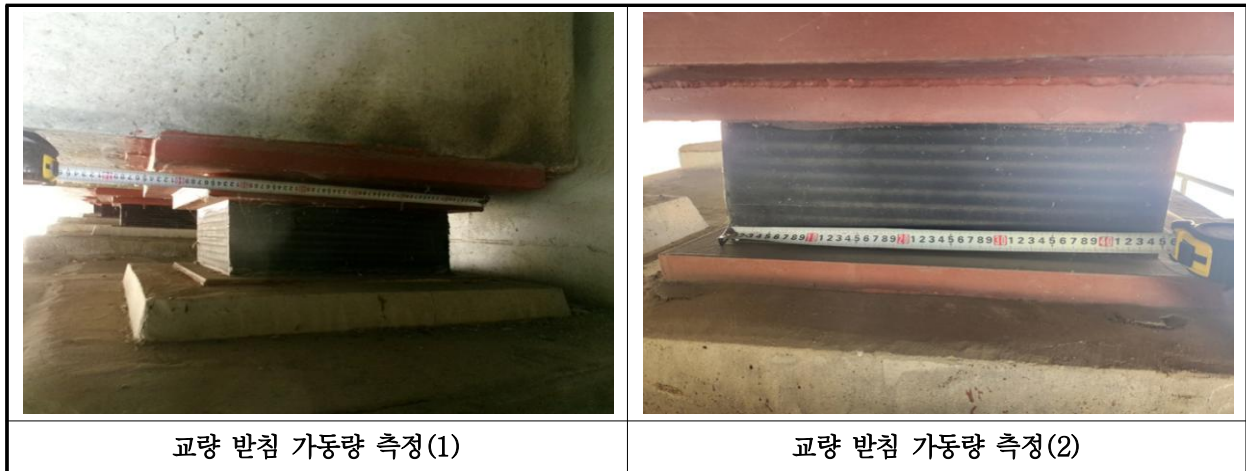
【사진 2.3.13】교량받침 이동량 측정
